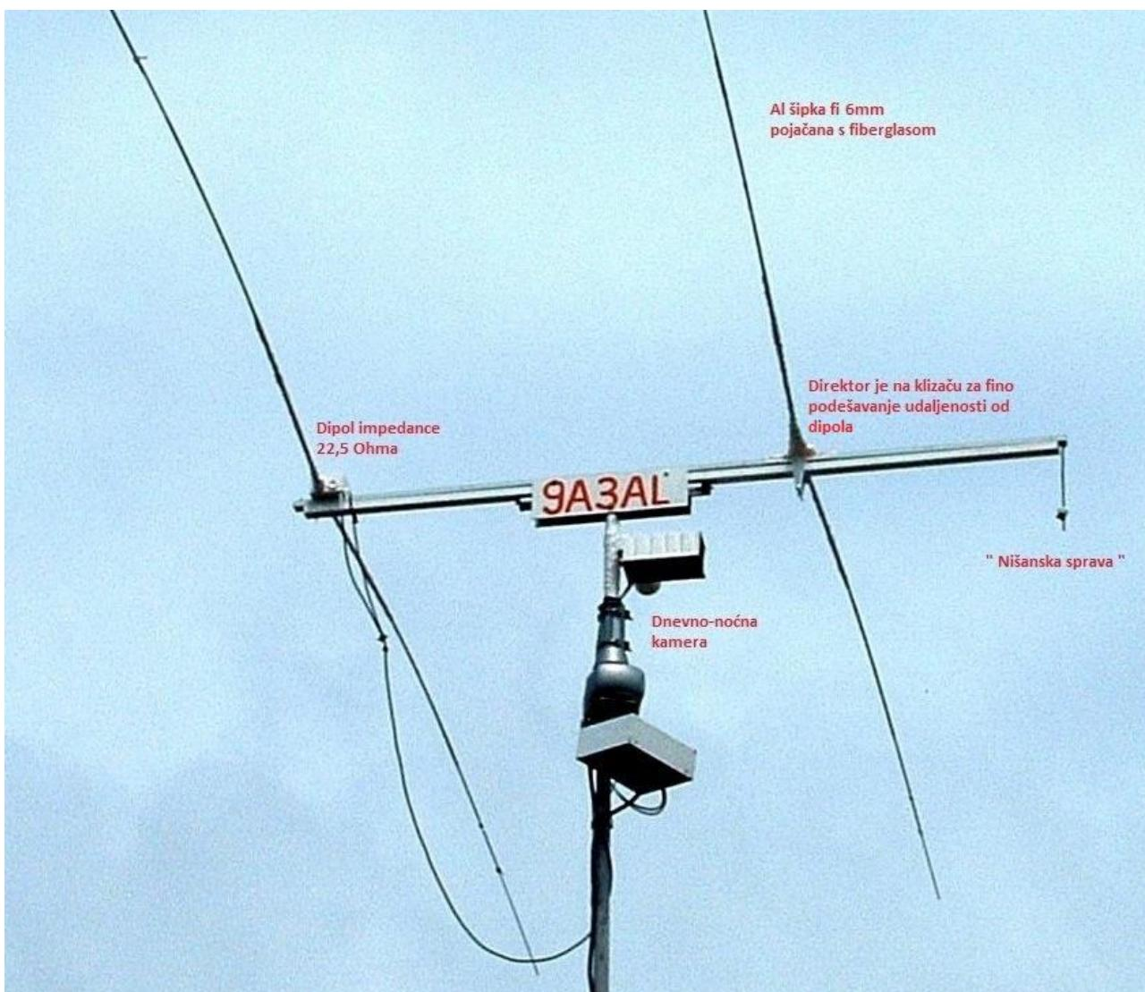
Kod izrađene antene posebna specifičnost su tanki aluminijumski elementi, zнатно pojačani sa stakloplastikom ([video](#)). Dva do četiri sloja vlakana za stakloplastiku su obmotana oko Al šipke Fi 6mm, uz "grif" s ručnom električnom bušilicom i malo čvršćim koncem. Poslije toga su slijedili premaz s poliesterskom smolom i zaštitno bojanje protiv UV zraka s običnim lakom koji je ostao od nekog drugog farbanja. Za dugotrajniju zaštitu može se kupiti boja proizvedena upravo za zaštitu od UV zraka.
