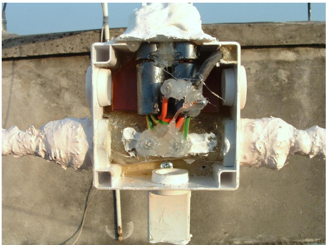
Na anteni je podvarijanta prilagodnog člana s izvodima i primara i sekundara na istoj strani. Na slici se vidi i primjena stakloplastike za realizaciju mehaničkog učvršćenja sredine razdvojenog dipola. Također je učinjena i zaštita spojeva od atmosferilija na bazi silikona.
